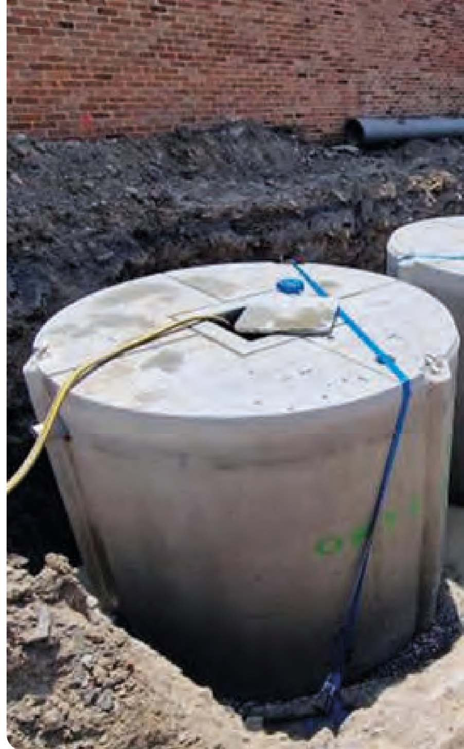
Installation de cuves : 2023
