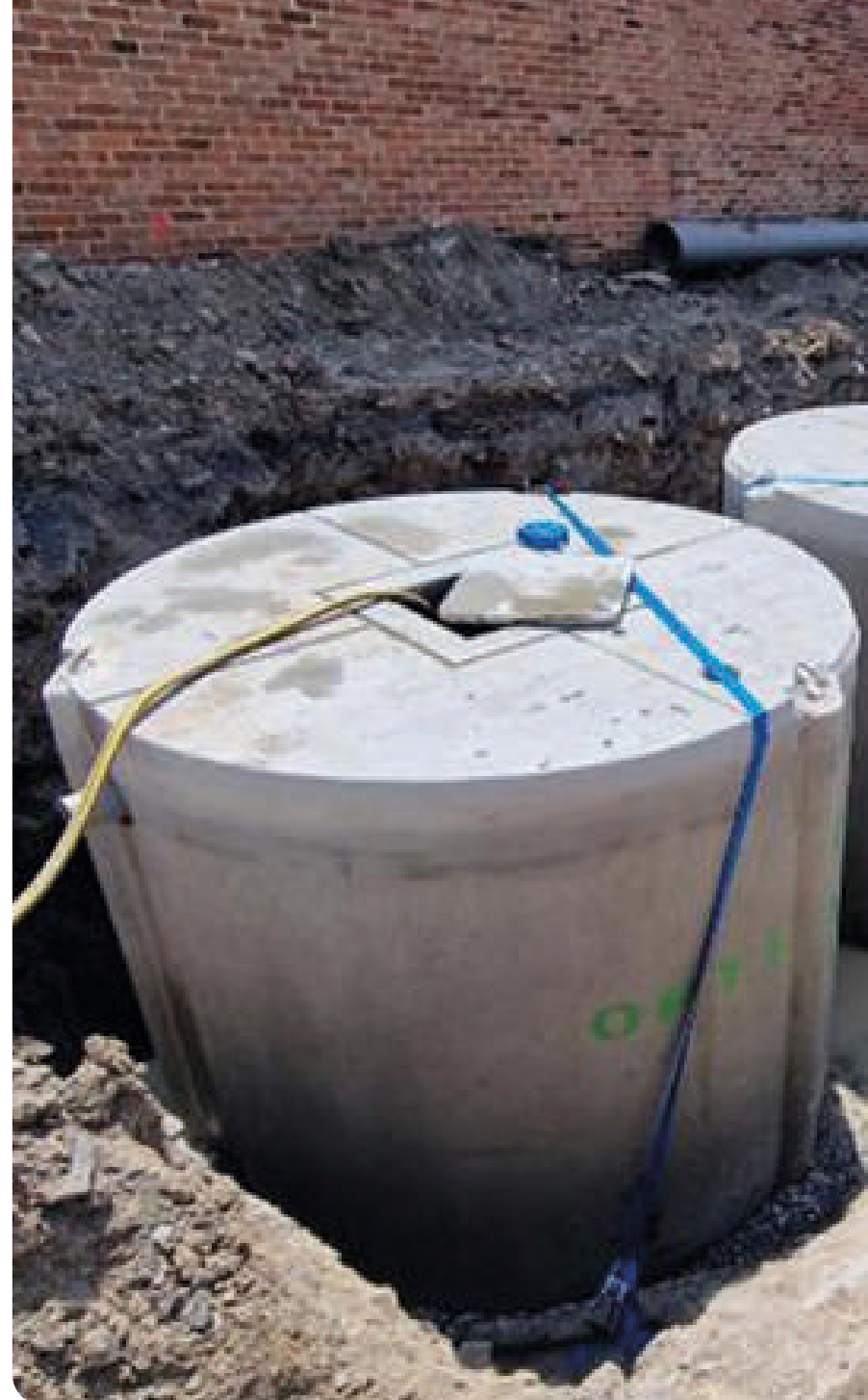
Installation de cuves : 2023
